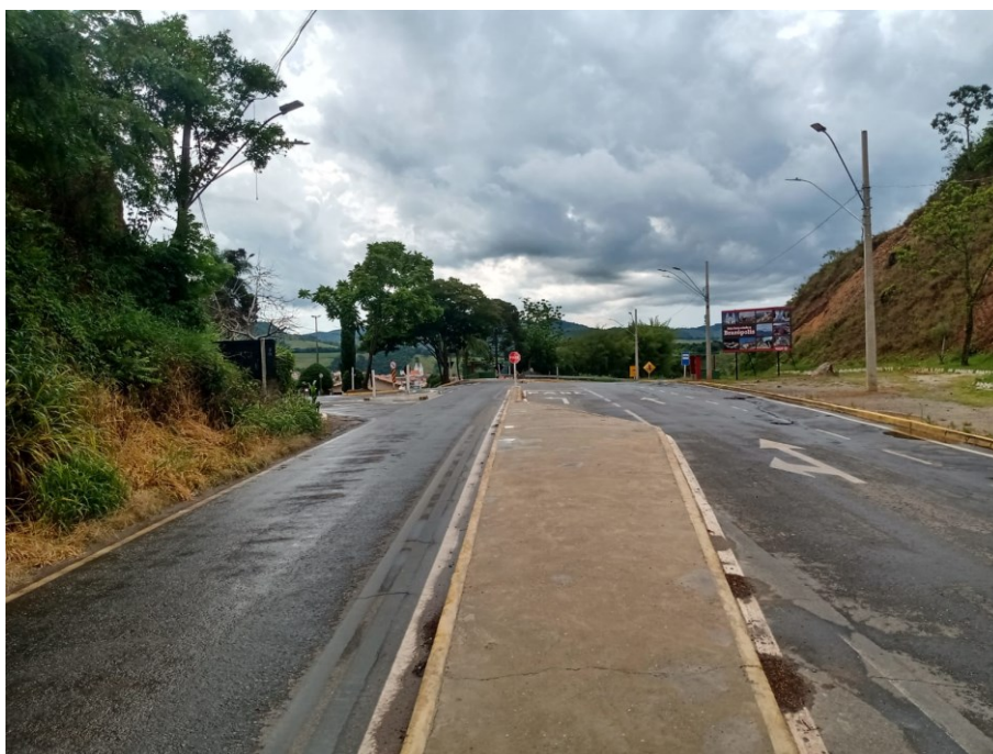
Figura 2 – VISTA DA RODOVIA MG-295 SENTIDO PIRANGUINHO-BRAZÓPOLIS
