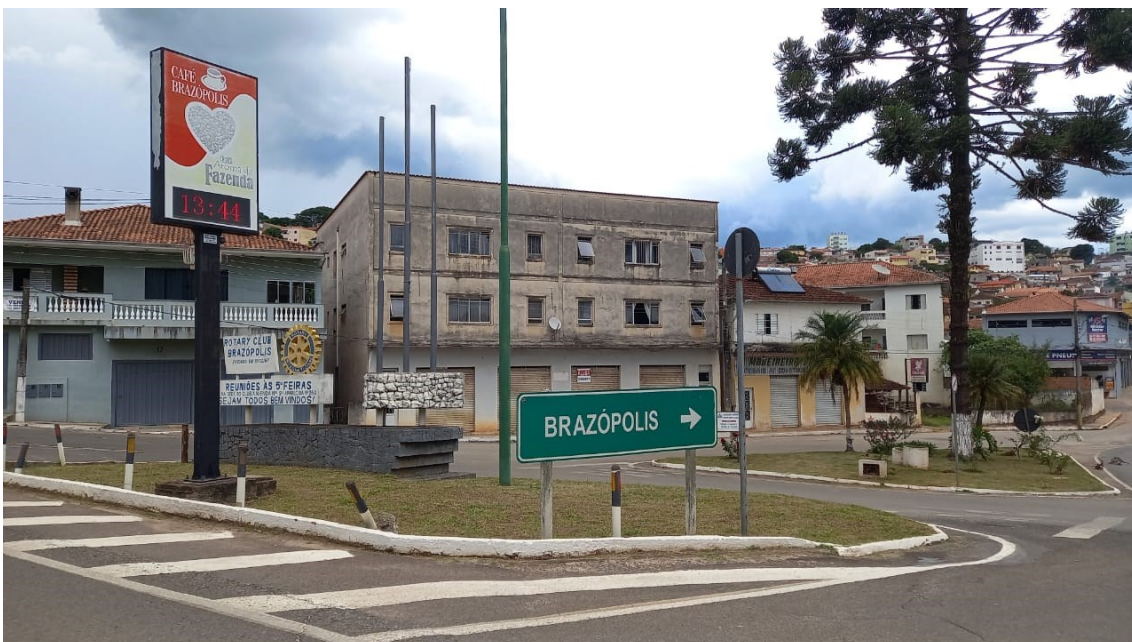
Figura 8 - VISTA DA RODOVIA MG-295 SENTIDO BRAZÓPOLIS-PIRANGUINHO – LOCAL DO TOTEM “ESTAIADO”
