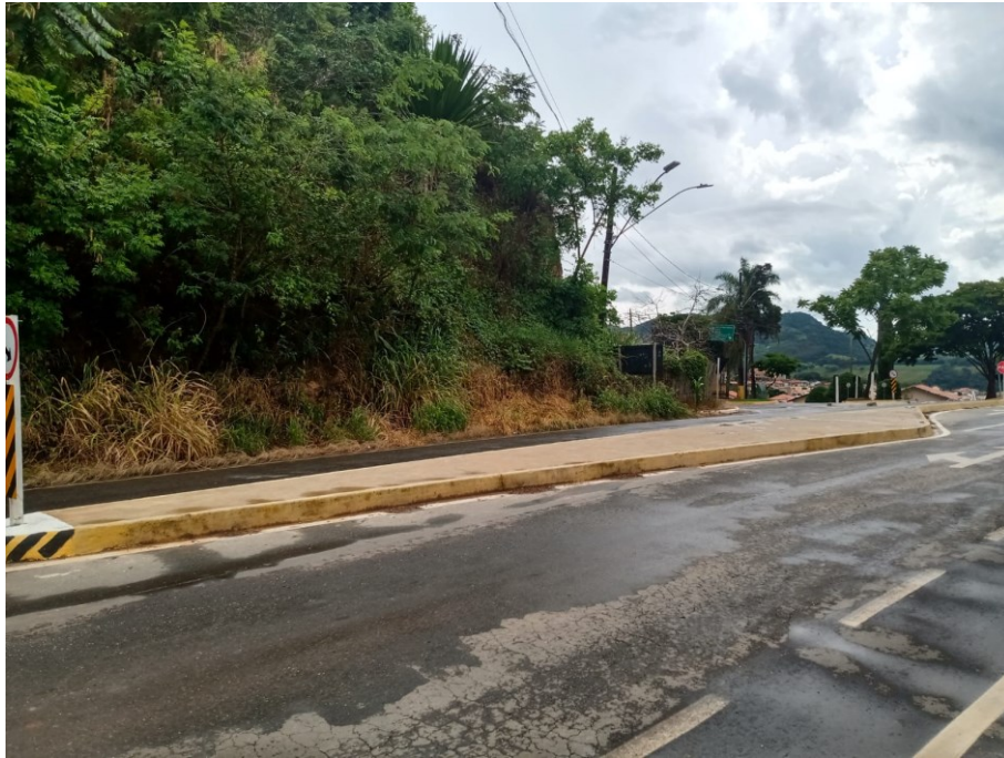
Figura 3 – VISTA DO ACOSTAMENTO DA RODOVIA MG-295 SENTIDO PIRANGUINHO-BRAZÓPOLIS
